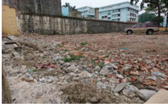
Hình 6. Tái chế vật liệu để cải tạo đất Gạch và bê tông vụn được sử dụng nguyên (không kiểm soát chất lượng)
